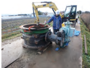
▲パイプライン仕切弁交換工事
