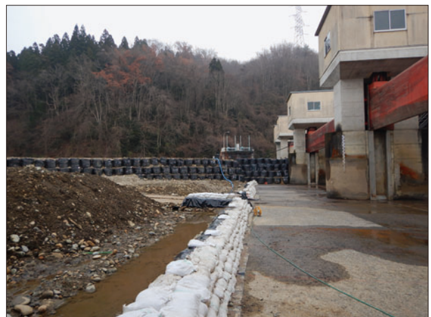
◀河川を半分締めきっての作業
