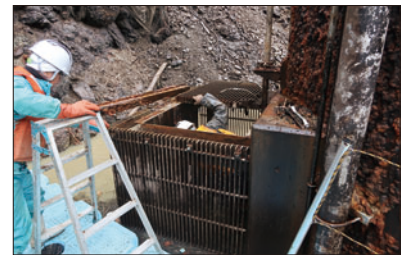
▲取水ゲートの水密ゴム更新
