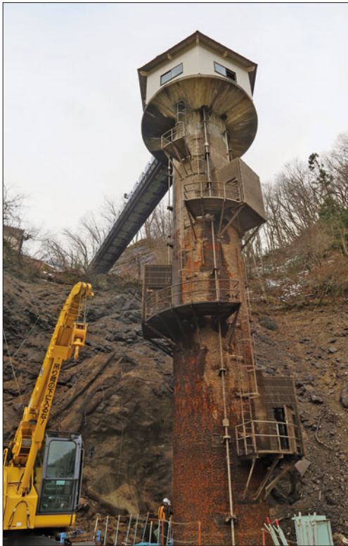
▲大平沼取水塔ゲート補修工事状況
