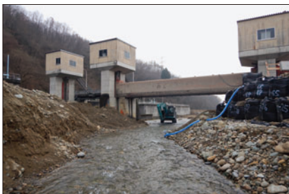
▲河川内作業（上流）
