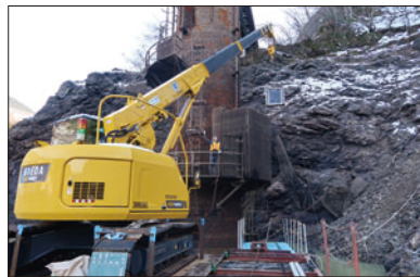
▲取水ゲート取外・取付
