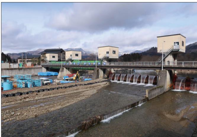
▲大平沼取水塔ゲート補修工事状況
