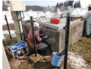
△日中幹線用水路 電気防食工事
