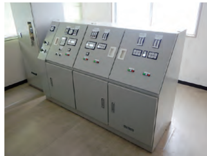
▽三吉頭首工 施設機械計測機器更新、河川ゲート開閉機点検
