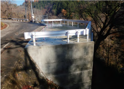
△大平沼発電所 仮設ヤード造成
