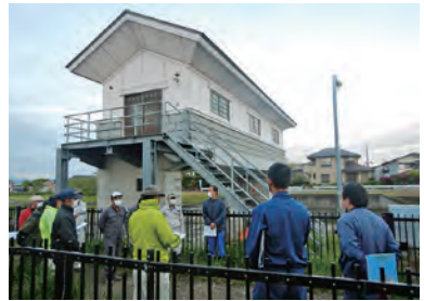
一の堰頭首工水利委員会
