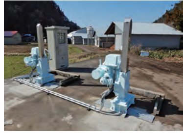
▽排砂ゲート電動化・河川ゲート塗装
