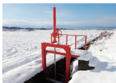
▲綱取用水路 ゲート更新・補修工事
