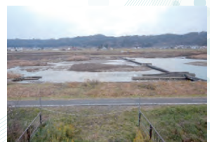
▲慶徳頭首工 河川内土砂移動工事
