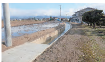
▲松野右岸用水路 更新工事 昨年度施工した範囲の下流部にて施工
