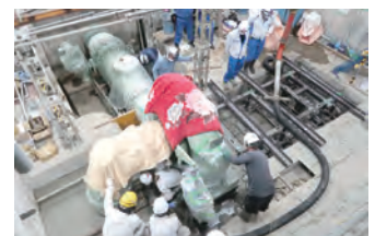
▲大平沼小水力発電所 発電機 (上から施工前、既設撤去、組立)
