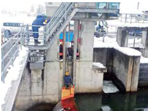
▲頭首工ワイヤーロープ交換
