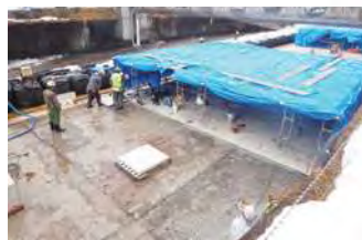
▲下台頭首工パネル設置状況
