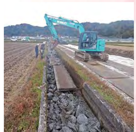
▲松野右岸用水路取り壊し
