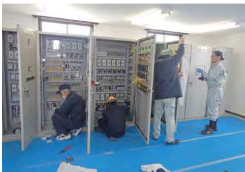
▲慶徳頭首工操作盤更新施工状況
