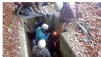
▲半在家用水路ゲート更新施工中
