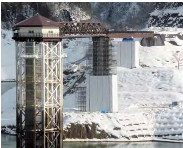
▲日中ダム管理橋耐震補強
