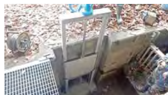
▲半在家用水路ゲート更新完了
