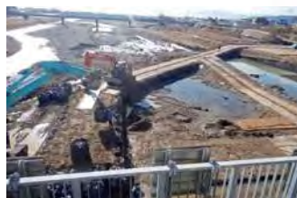
▲松野頭首工仮設施工状況
