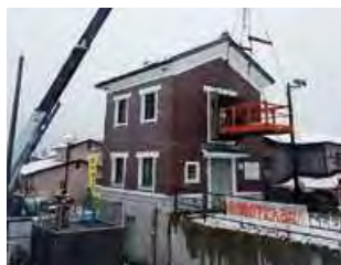
▲機材搬入状況
