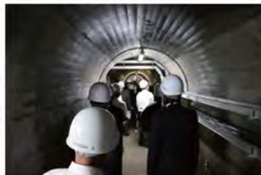
新宮川ダム監査廊
