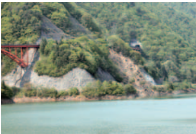
国道121号線脇の崩落箇所
