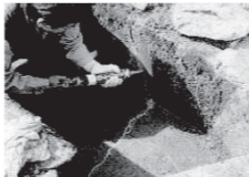
水路のひび割れ補修
