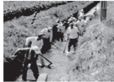
水路の泥上げ
