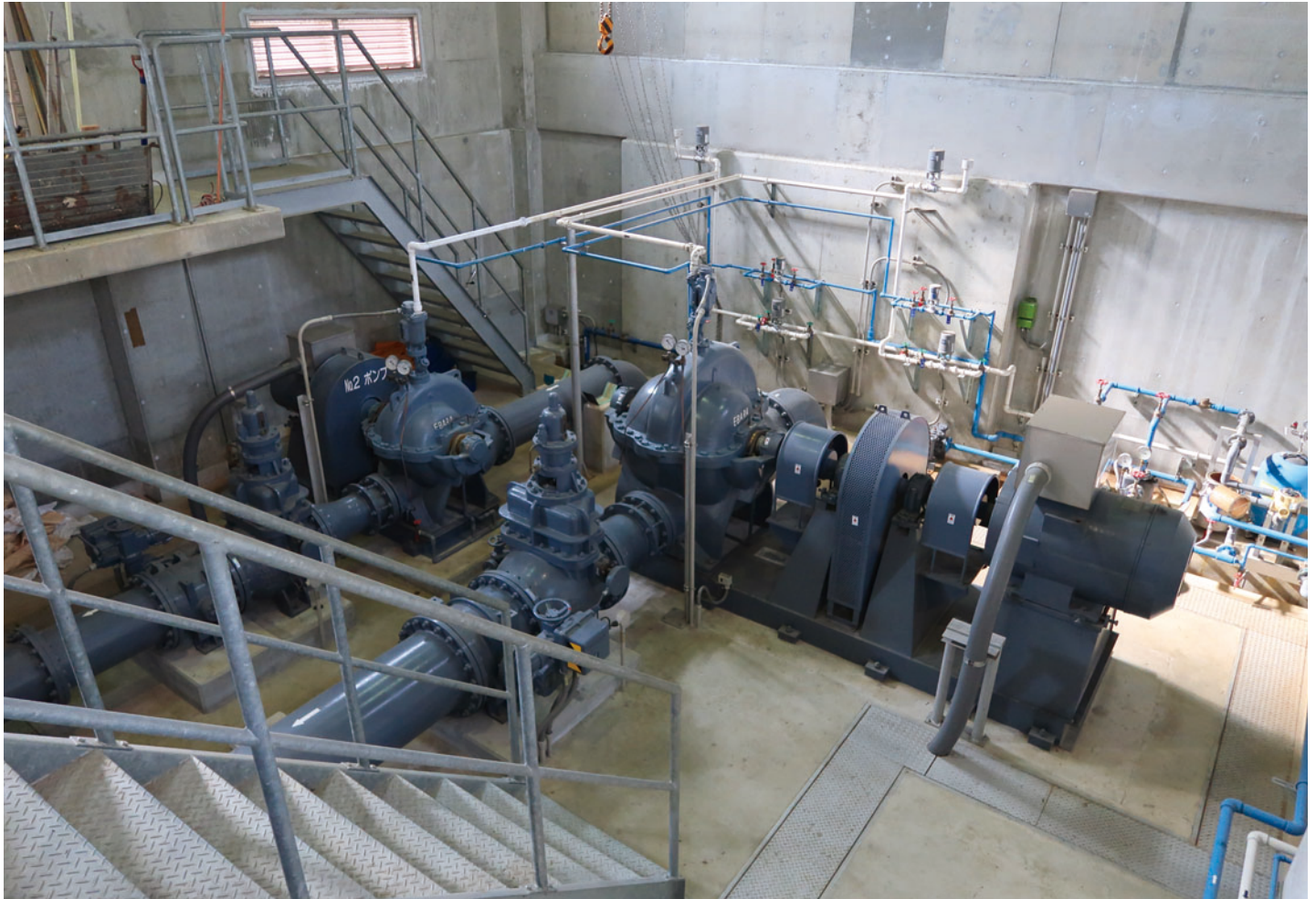
【 遠田貝沼揚水機場 】
