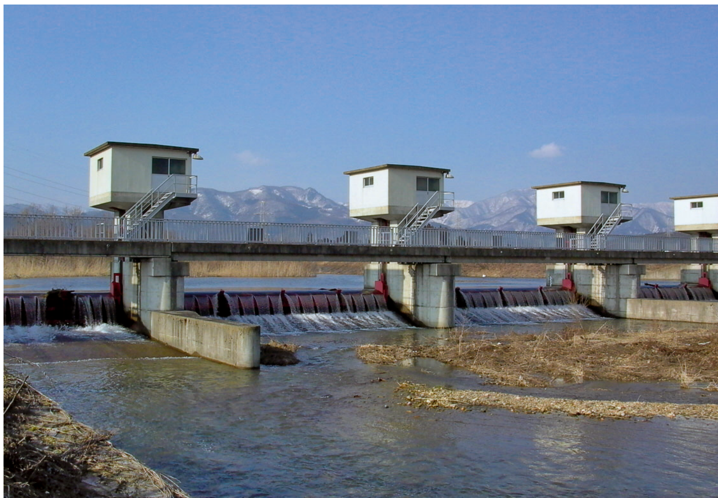
【 松野本頭首工 】
