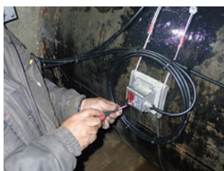
▲幹線用水路水位計更新(電波式水位計・超音波流量計)
