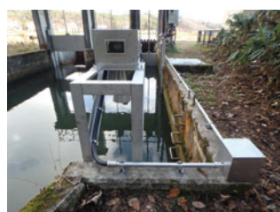
▲幹線用水路水位計更新(電波式水位計・超音波流量計)
