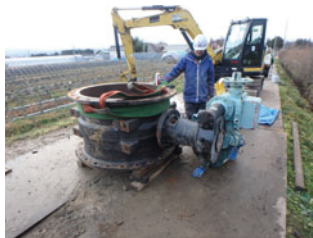
▲パイプライン仕切弁交換工事
