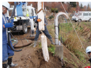
▲鋼管接続部 電気防食対策
