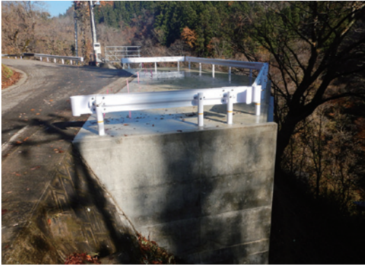
△大平沼発電所 仮設ヤード造成
