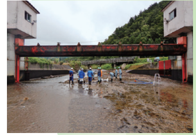
◁日中幹線制水工ユニット交換
