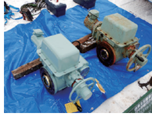
◁日中幹線制水工ユニット交換
