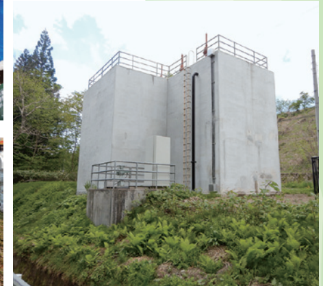
△日中幹線第1・2・3号分水工 漏水対策工事
