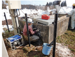
△日中幹線用水路 電気防食工事
