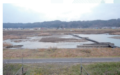
▲慶徳頭首工 河川内土砂移動工事
