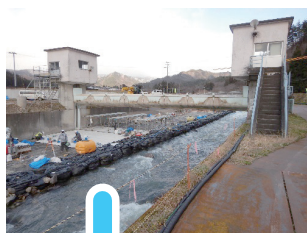
▼下台頭首工 エプロン 河川を半分閉めきって施工中
