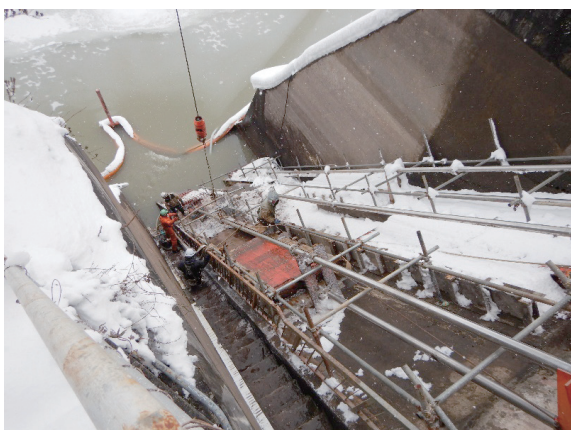
▲関柴ダム 取水ゲート 取水ゲート等の補修のためダムの水位を下げて作業中
