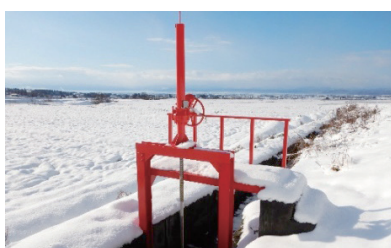
▲綱取用水路 ゲート更新・補修工事
