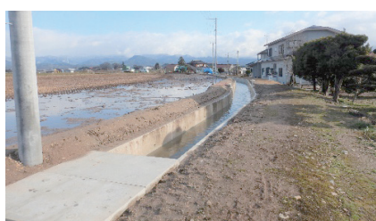
▲松野右岸用水路 更新工事 昨年度施工した範囲の下流部にて施工
