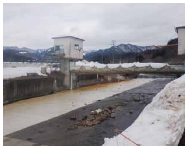
▲エプロン パネル設置完了
