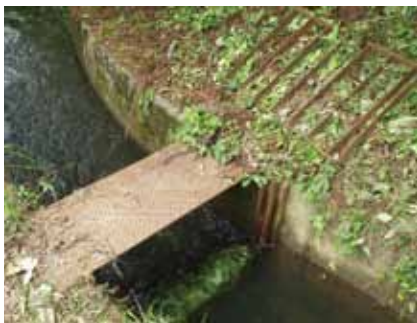
▲施工前（半在家用水路）
