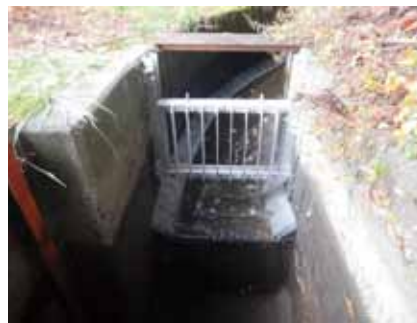
▲施工後（半在家用水路）
