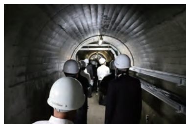
新宮川ダム監査廊
